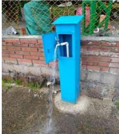
*Figura 2. Nueva estructura de puntos de muestreo*
