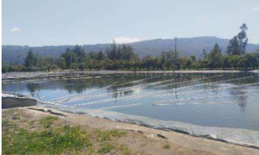
arcilla compactada, taludes con pendiente 1V:1.5H sin recubrimiento y borde libre de 0.3m. La laguna presenta una coloración verde y arrastre de sólidos.
