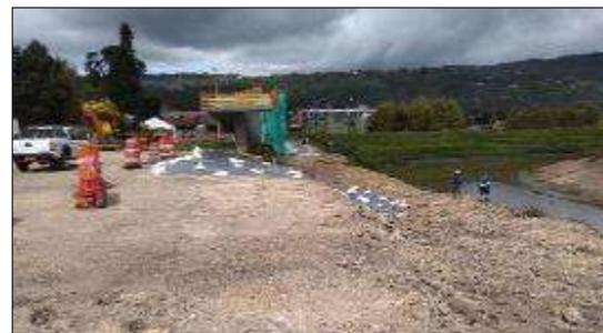
En el sector de centro chía, donde se presentaron los diferentes desempates de la tubería de la red matriz, el terreno se encuentra inestable. Por lo cual, la concesionaria de la vía planeó la construcción de pilotes para la contención del terreno y la demolición del puente peatonal, Por todo esto, fue necesario realizar el seguimiento diario con topografía al terreno, con el fin de identificar posibles movimientos que pudieran ocasionar daños en la tubería.
