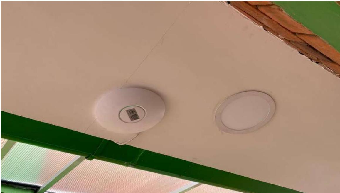
En el mes de Marzo se realizó la instalación de un Access Point Unifi AP en el área Comercial para garantizar el correcto acceso a la red wifi de la entidad ya que en repetidas ocasiones se generaban caídas de red en los portátiles por la poca fuerza de la señal.
