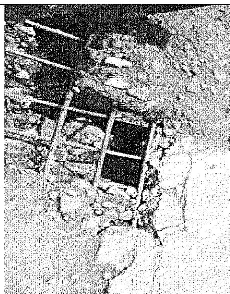
Imagen 2: Relleno del colector y la cuneta expuesto a la intemperie.
