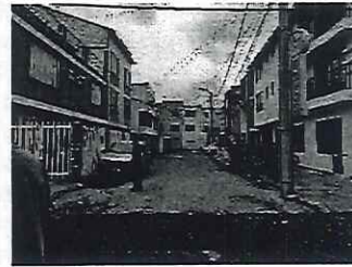
Imagen 10. Estado de un tramo de vía actualmente
