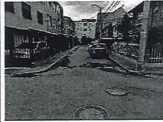
Imagen 8. Estado de un tramo de vía actualmente
