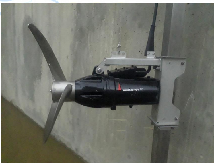
Ilustración 31. Fotografía Agitadores marca GRUNDFOS.
