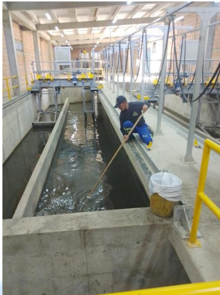
Ilustración 65. Proceso de Limpieza de Partículas sobrenadantes y basura en el desarenador
