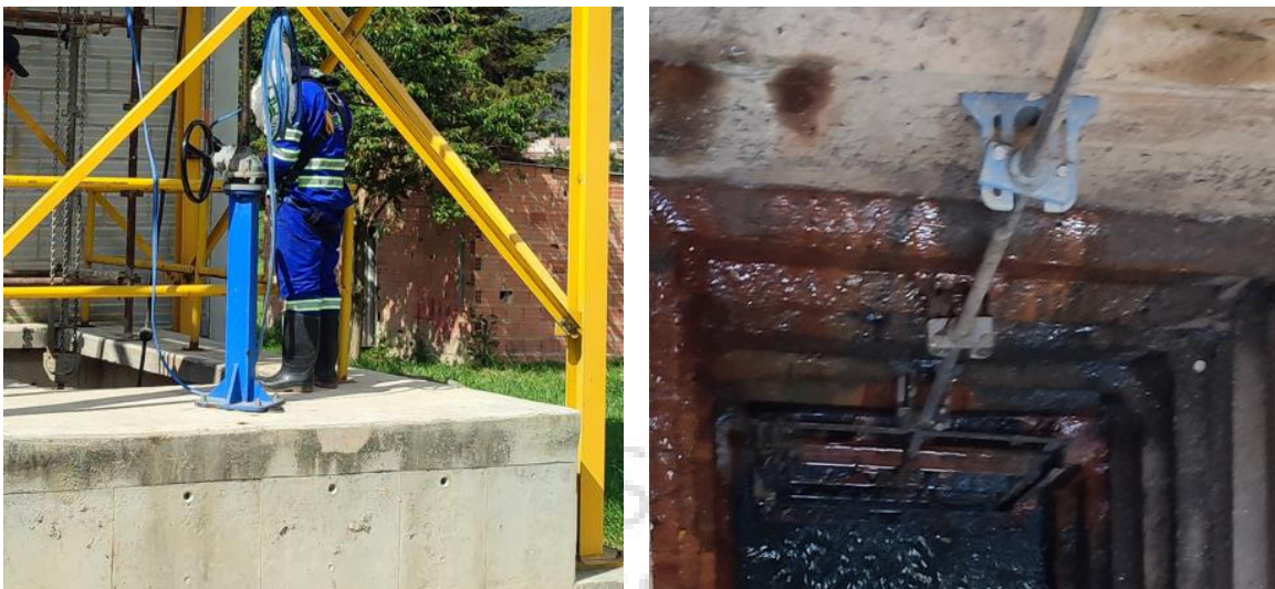
Ilustración 5. Fotografía Izquierda Volante de Operación de la Compuerta. Fotografía Derecha de la compuerta deslizante en el interior de la Camara de Gruesos
