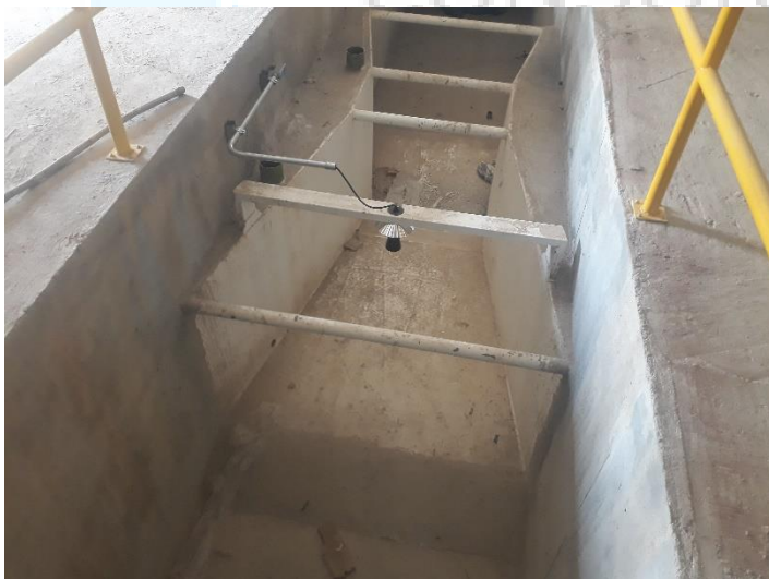
Ilustración 17. Fotografía Sensor Ultrasónico de Nivel y Canaleta Parshall de 36" Previa a su puesta en marcha.
