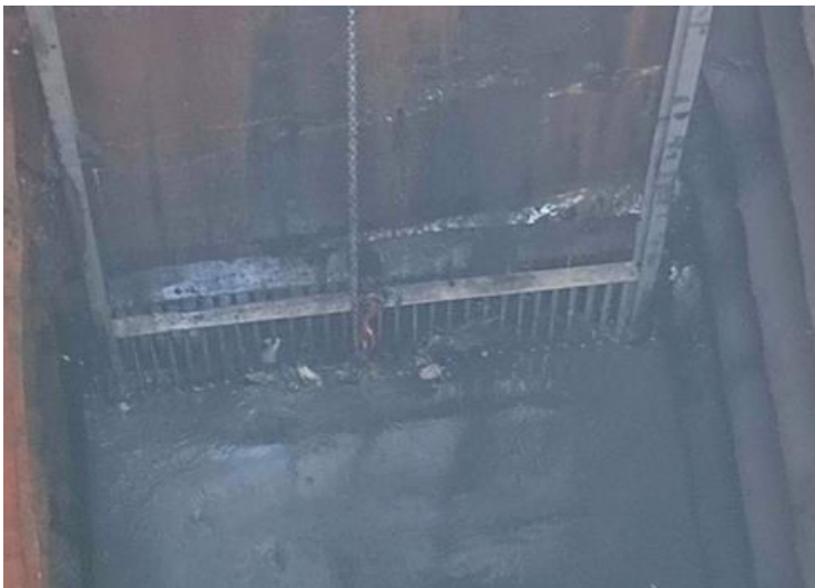
Ilustración 7 Fotografía Rejilla Deslizante en el Interior de la Camara y a la Derecha la estructura de izaje
