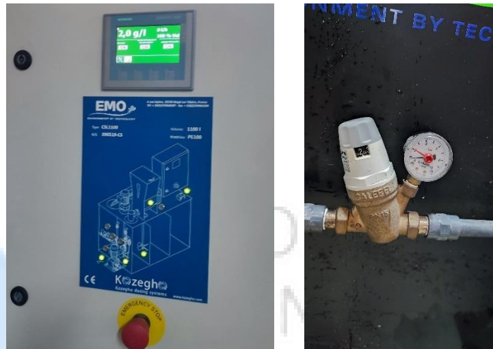
Ilustración 96. Tablero Dosificador de Polímero (Izquierda) Válvula de Presión Caudal para Solución de Polímero (Derecha)
