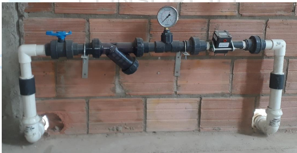
Ilustración 45. Fotografía Manifold Dosificador de Gas Cloro
