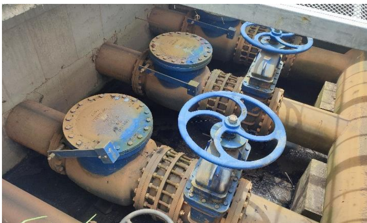
Ilustración 61. Fotografía Manifold EBAR con sus respectivas válvulas anti retorno, unión autoportante y válvula de corte de 20".
