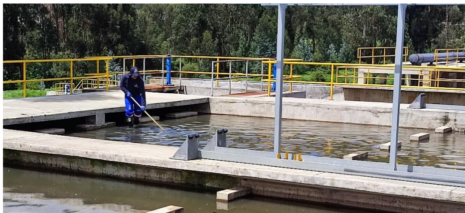
Ilustración 69. Lavado de las canales del Sedimentador Primario.
