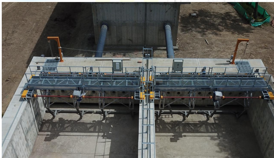
Ilustración 23. Fotografía Área Barredores Sedimentado Primario Antes del Llenado.
