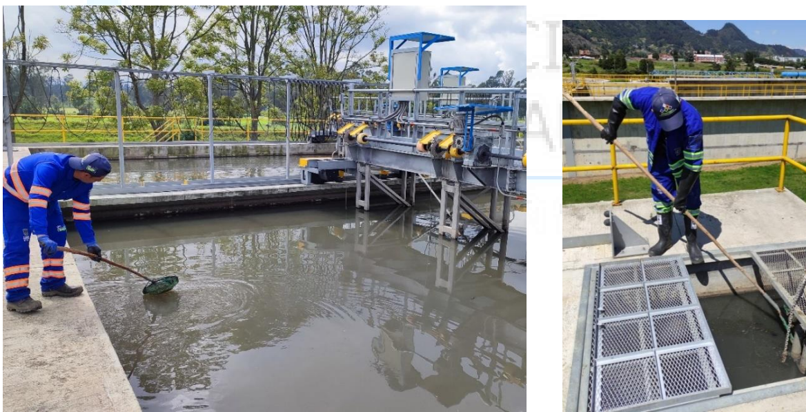
Ilustración 70. Proceso de Limpieza sobrenadantes Sedimentador Primario.
