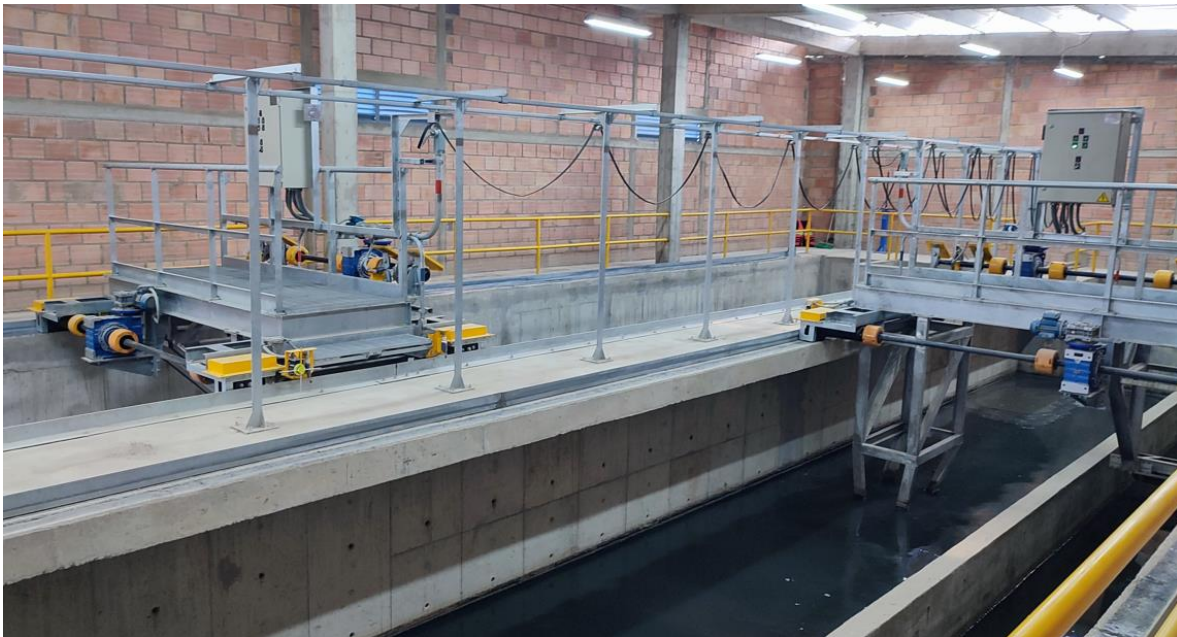
Ilustración 64. Canales de Desarenado – Desengrasado con sus puentes barredores
