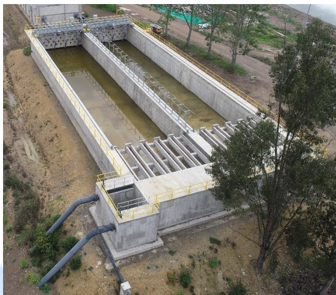
Ilustración 22. Fotografía Área Sedimentado Primario Antes del Llenado.
