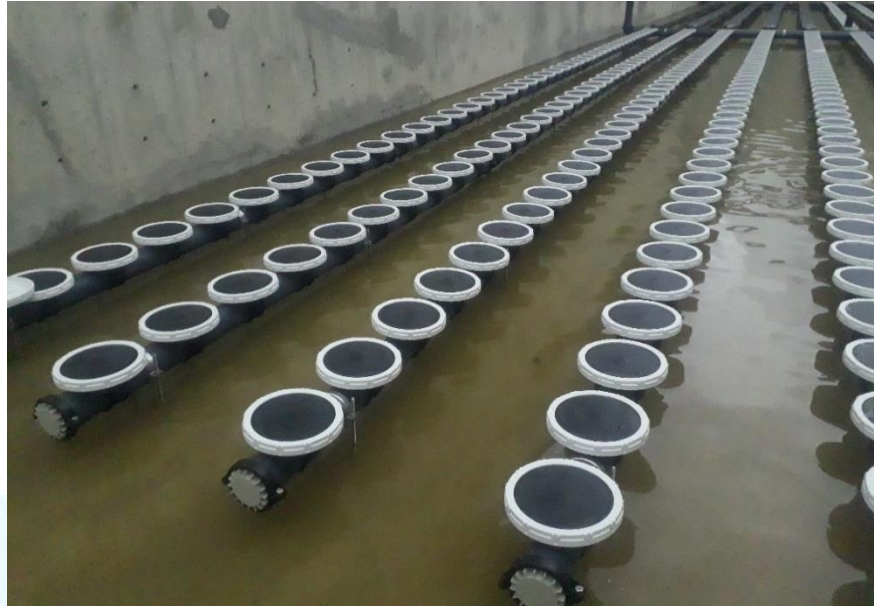
Ilustración 28. Fotografía Difusores en Reactores Antes del Llenado.
