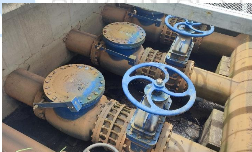
Ilustración 10. Fotografía Manifold EBAR con sus respectivas válvulas anti retorno, unión autoportante y válvula de corte de 20".
