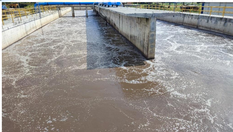
Ilustración 72. Fotografía Reactor de Aireación Extendida en condición estabilizado
