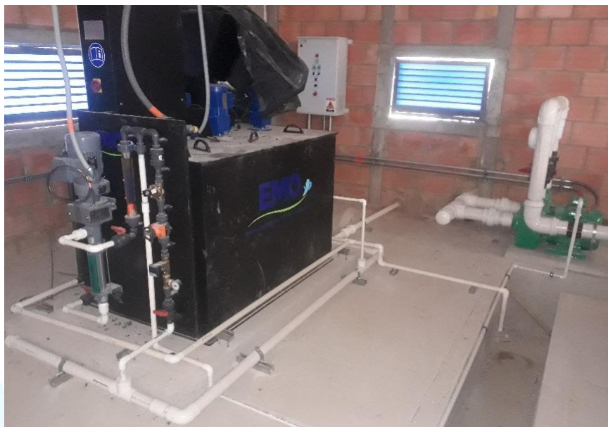
Ilustración 48. Fotografía Estación Dosificadora de Polímero
