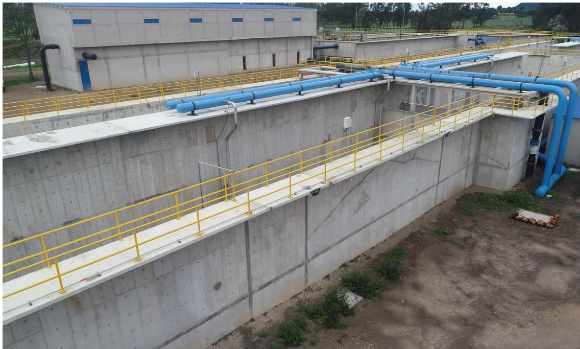
Ilustración 30. Fotografía Aérea Líneas de Aire Reactores.
