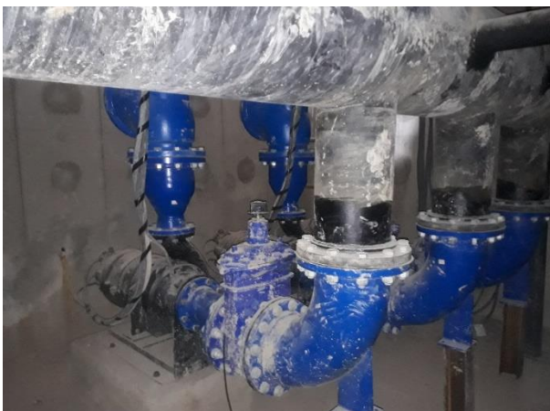
Ilustración 87. Manifold Succion RAS bomba S1.4
