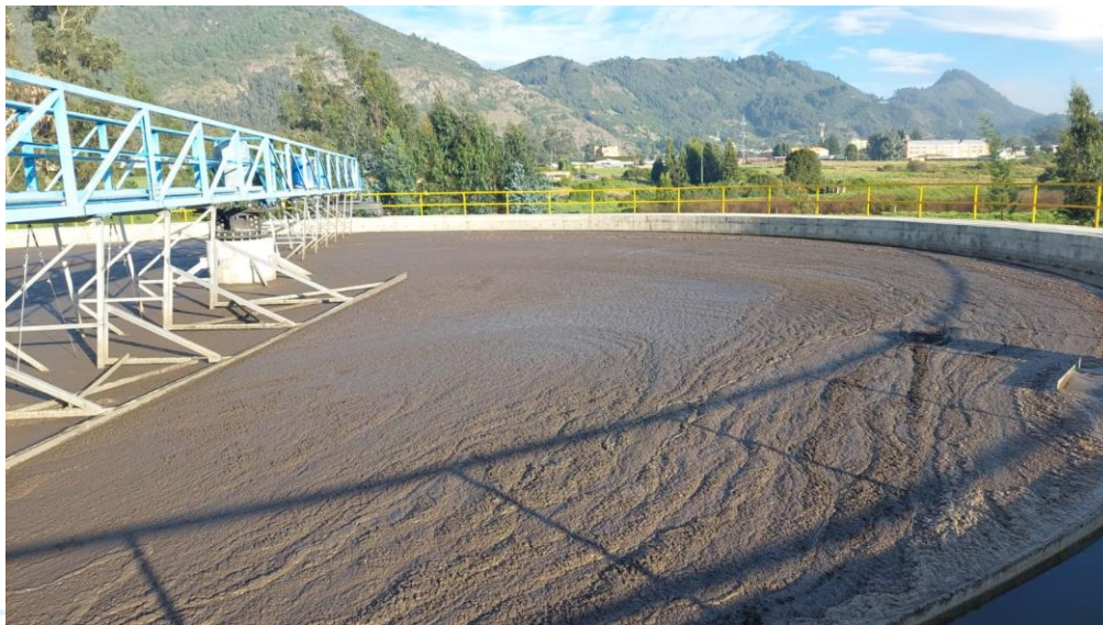
Ilustración 111. Fenómeno de Bulking en Sedimentadores Secundarios por exceso de bacterias filamentosas
