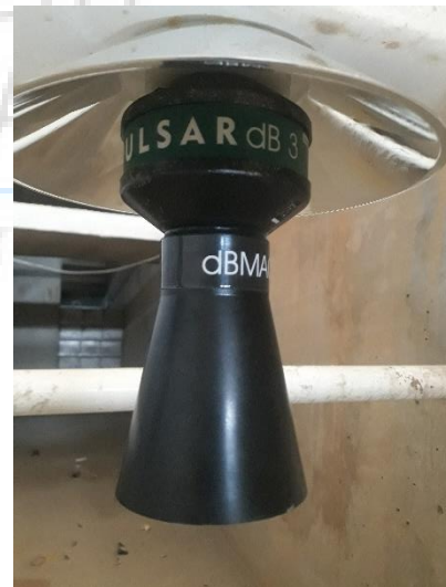
Ilustración 17. Fotografía Sensor Ultrasónico de Nivel y Canaleta Parshall de 36" Previa a su puesta en marcha.
