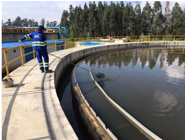
Ilustración 76. Proceso de retiro de sobrenadantes y partículas flotantes en los Sedimentadores secundarios
