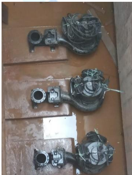
Ilustración 8. Fotografía General Bombas S2 de la EBAR durante su instalación mecánica.
