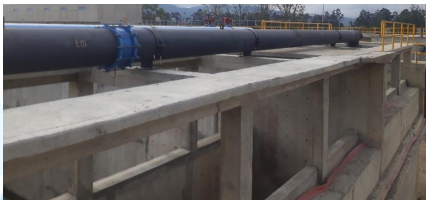
Ilustración 38. Fotografía Panorámica tubería recirculación de lodos RAS
