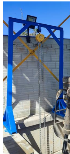
Ilustración 7 Fotografía Rejilla Deslizante en el Interior de la Camara y a la Derecha la estructura de izaje
