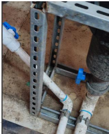
Ilustración 78. Válvulas de Purga en Filtro Banda y Reguladoras de presión
