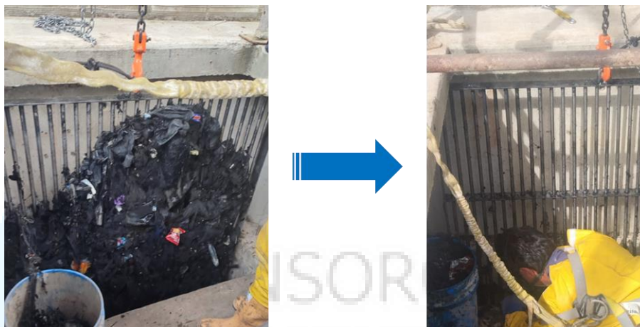
Ilustración 56. Proceso de Limpieza de la Rejilla Deslizante
