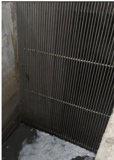
Ilustración 16. Fotografía Reja Manual de Cribado en Desarenador
