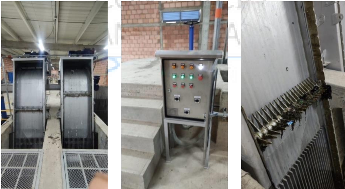
Ilustración 62. Rejas Mecánicas Desarenador
