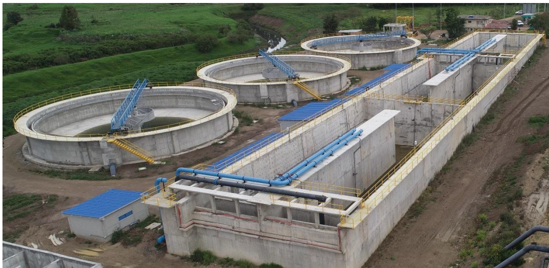
Ilustración 26. Fotografía Aérea Tratamiento Secundario Antes del Llenado.
