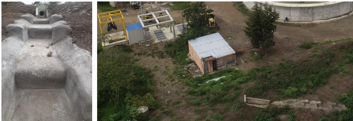
Ilustración 52. Alivio en caso de emergencia de la EBAR, en canal de sacos de suelo cemento.
