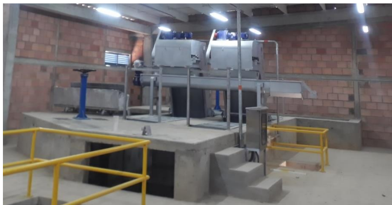
Ilustración 13. Fotografía Rejas Mecánicas y Tornillo Horizontal Previa a su puesta en marcha.
