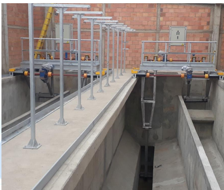
Ilustración 18. Fotografía Barredores Desarenador-desengrasador Previa a su puesta en marcha.
