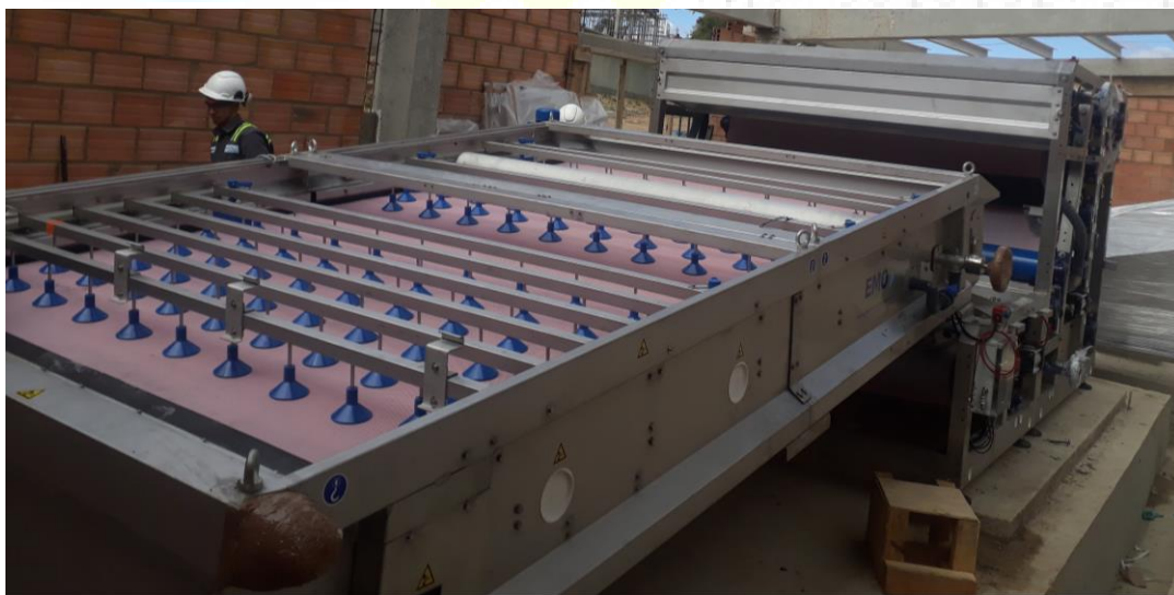
Ilustración 47. Fotografía Filtro Banda y Mesa Espesadora de Lodo
