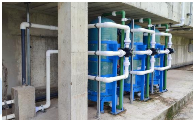
Ilustración 80. Cuerpos Filtrantes de la Planta de Servicio
