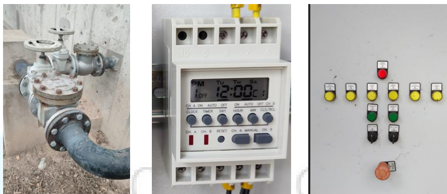
Ilustración 71. Fotografía Izquierda Válvulas de Purga de Lodos Primario. Centro Timer de configuración de ciclos. Derecha Tablero bombas de Purga Primario
