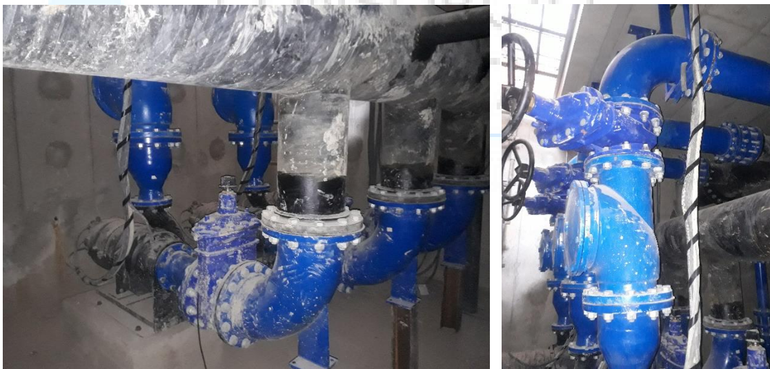
Ilustración 37. Fotografías Manifold RASWAS
