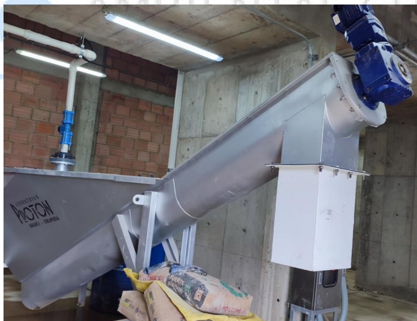
Ilustración 21. Fotografía Clasificador de Arenas
