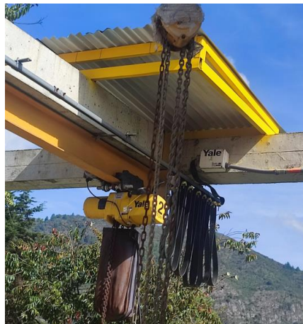
Ilustración 60. Polipasto mecánico para retiro de bombas
