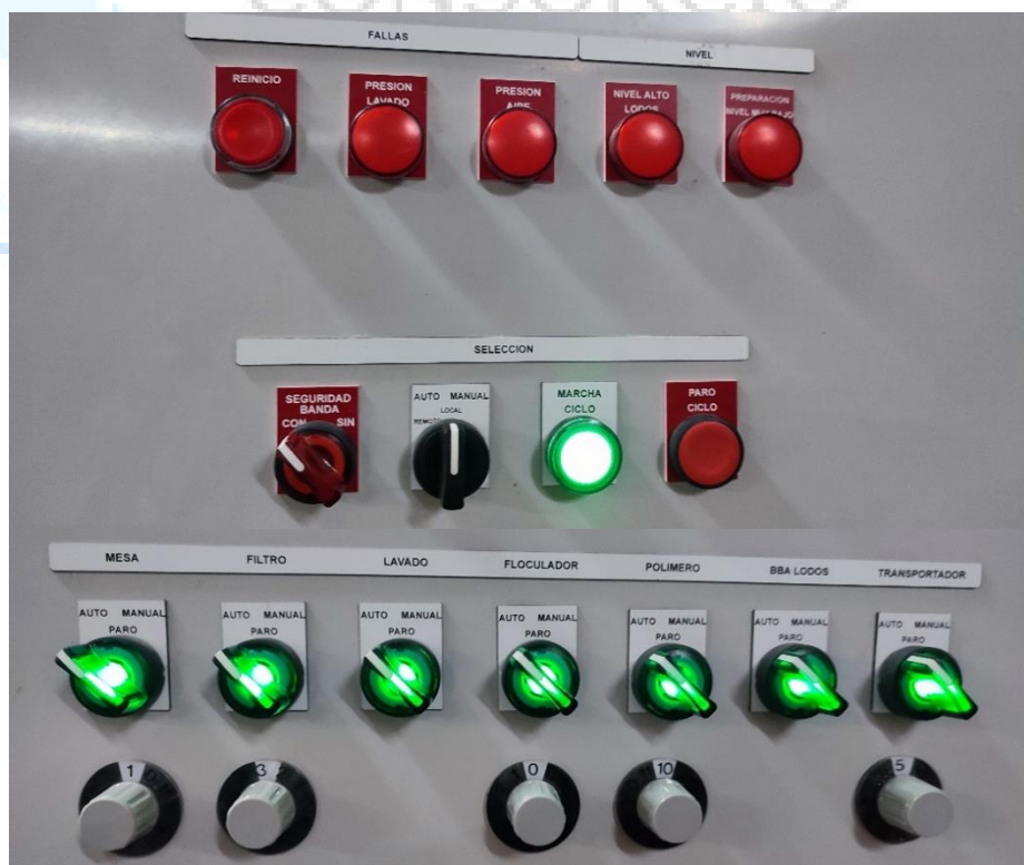
Ilustración 95. Tablero de Operación Equipo EMO (Espesamiento, Deshidratación)
