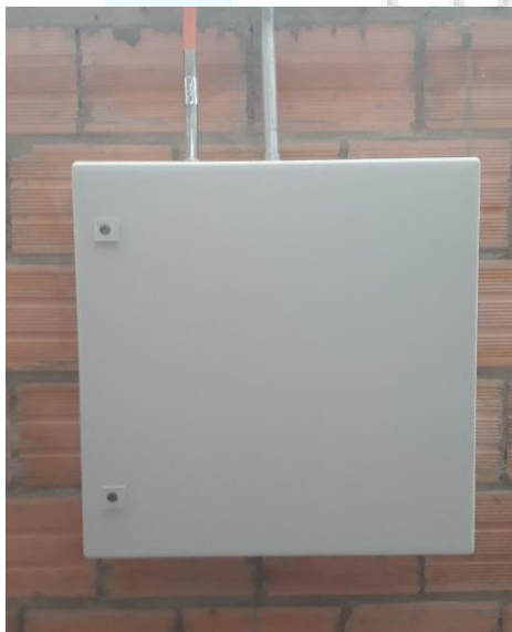
Ilustración 33. Fotografía Centro de Lectura Sensor de Oxígeno Disuelto en Reactores.
