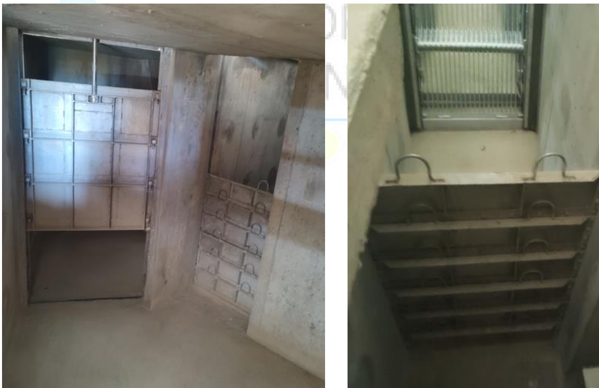
Ilustración 15 Fotografía compuerta deslizante 28" para canal de reja manual a la izquierda y compuerta stop log para rejas mecánicas a la derecha
