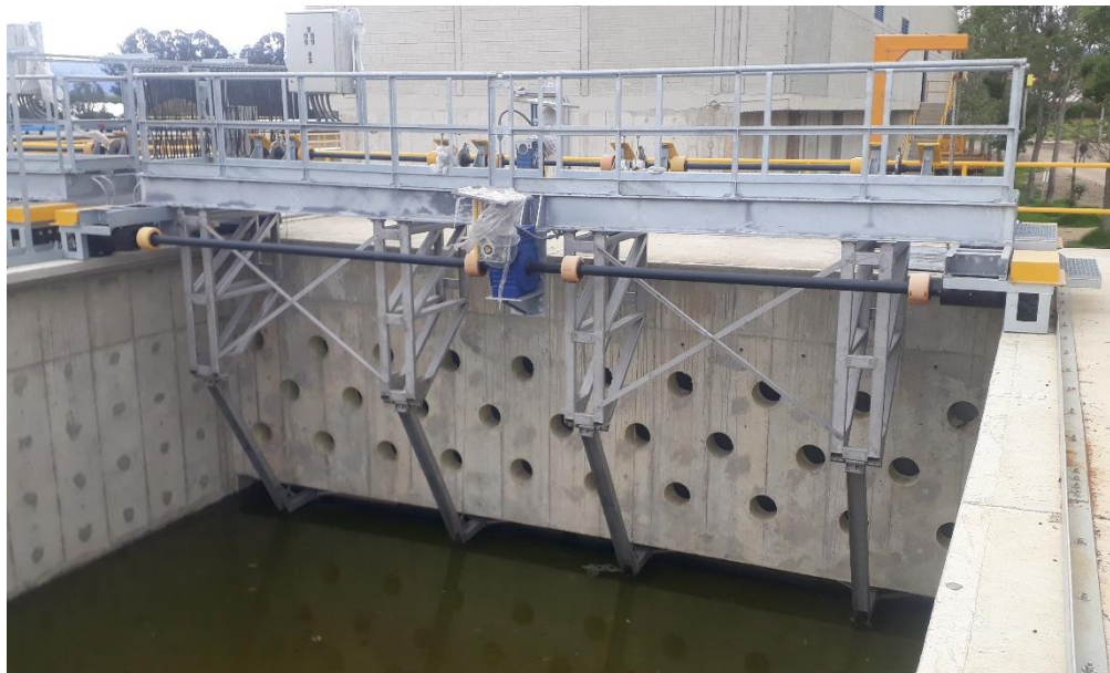
Ilustración 24. Fotografía Barredores Sedimentado Primario Antes del Llenado.
