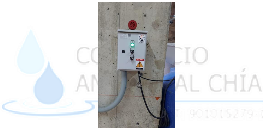
Ilustración 67. Tablero de Control y Operación Bomba de Excesos de la extracción y clasificación de arenas.
