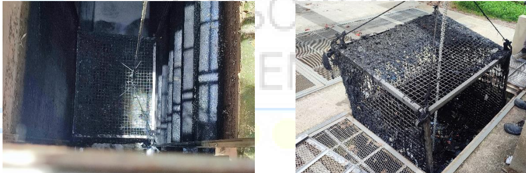
Ilustración 58. Canasta de Gruesos durante 48hrs de operación
