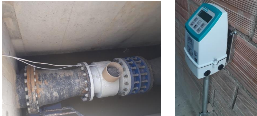
Ilustración 11. Fotografía Macromedidor de 16" Caudal Bombeado y su lector.
