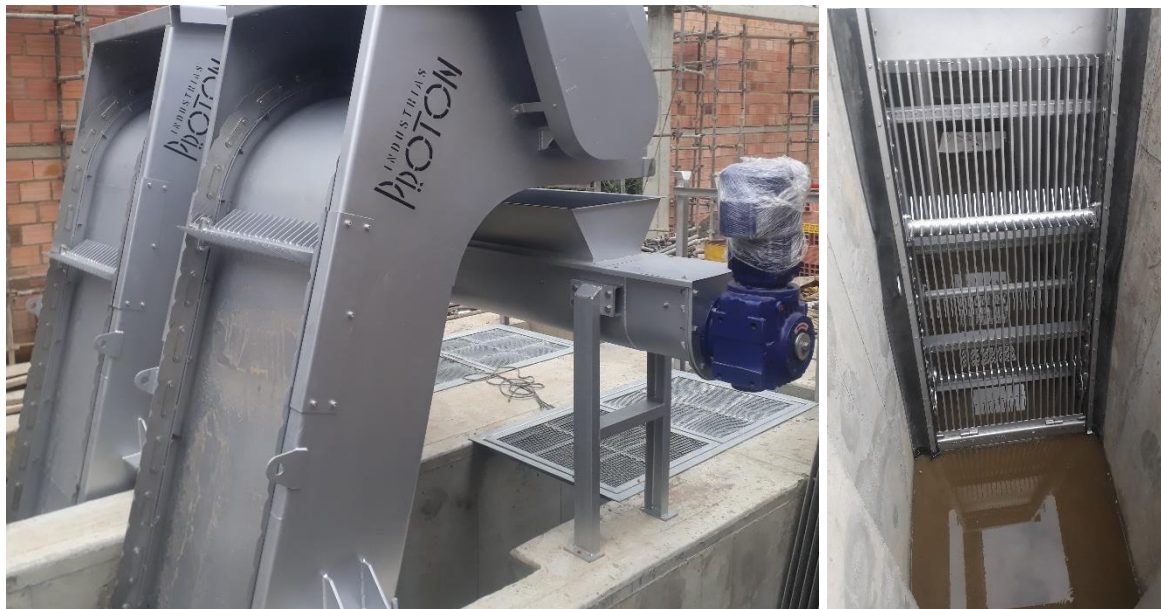
Ilustración 14. Fotografía Rejas Mecánicas Previa a su puesta en marcha.
