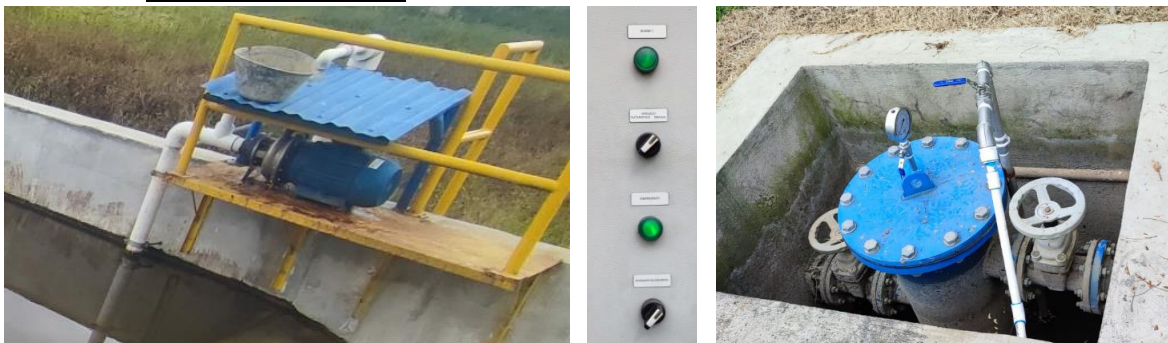
Ilustración 85. (a) Bomba de Servicio (b) Tablero Bomba (c) Cuerpo Filtrante
