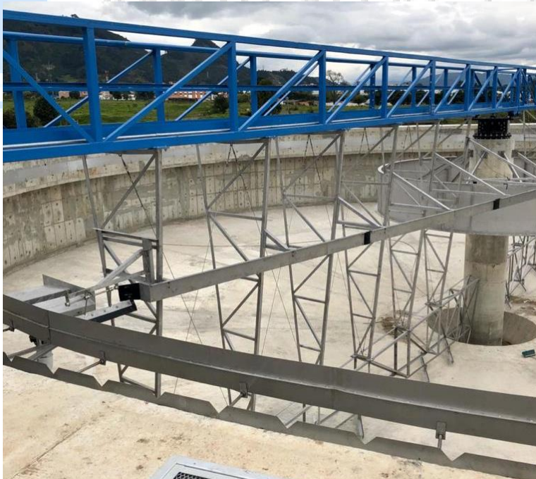
Ilustración 35. Fotografía Panorámica Barredores Sedimentadores Secundarios antes del llenado
