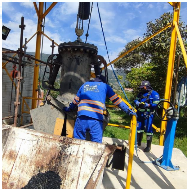
Ilustración 55. Operación Cuchara Bivalva
