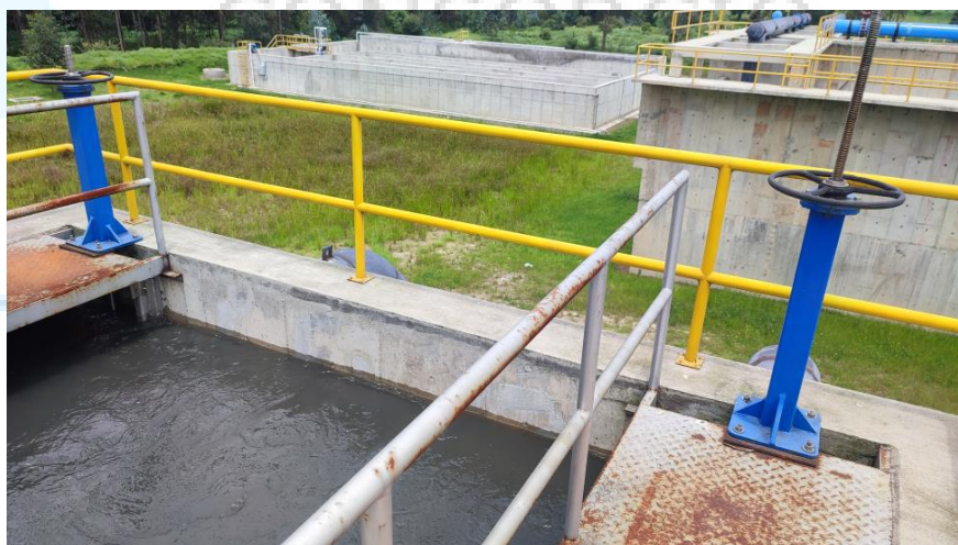
Ilustración 68. Válvulas de compuerta de 20" de Paso de Tratamiento Primario a Reactores
