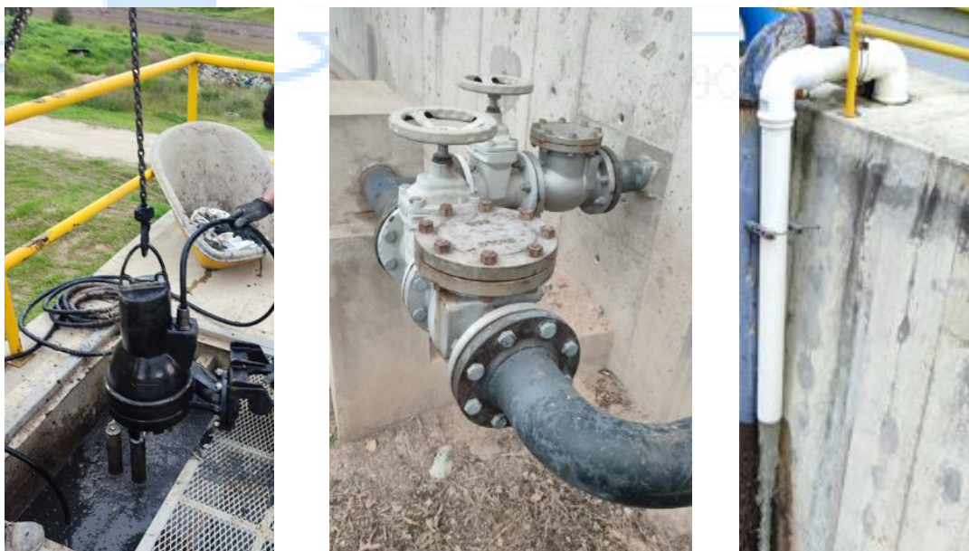
Ilustración 25 Línea d Purga de Lodos Primario (Izquierda Bomba SL1.30 Centro Juego de Válvulas Derecha Red PVC Presión Blanco Llegada de la purga al Digester)
