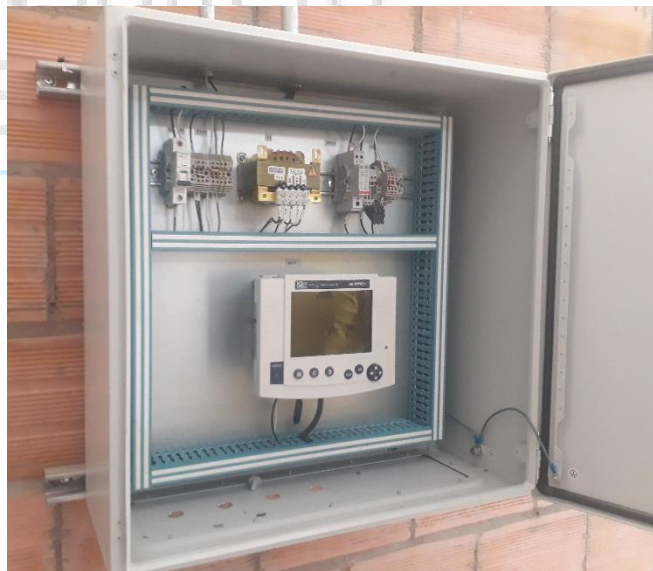
Ilustración 33. Fotografía Centro de Lectura Sensor de Oxígeno Disuelto en Reactores.
