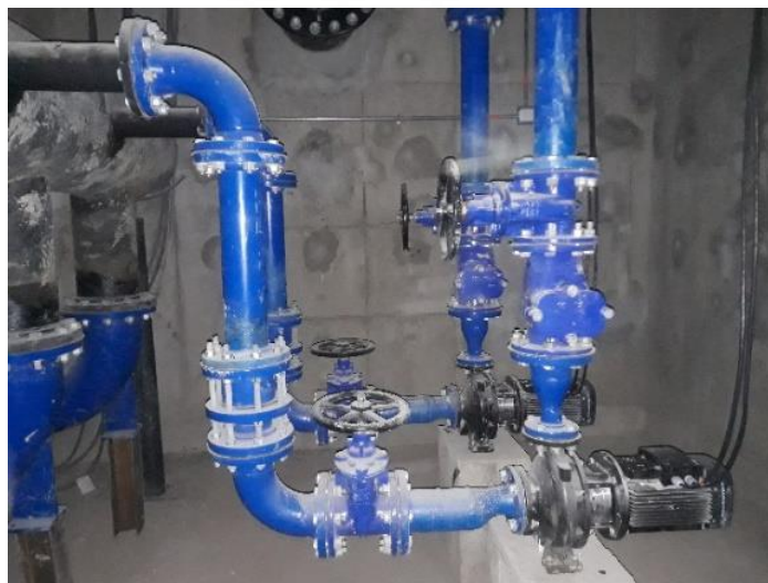
Ilustración 39. Fotografía Panorámica Manifold sistema WAS
