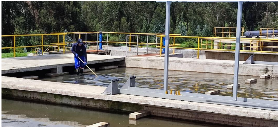
Ilustración 21. Lavado de las canales del Sedimentador Primario.
