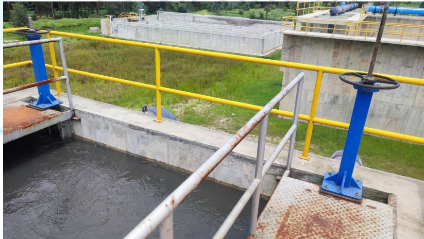
Ilustración 20. Válvulas de compuerta de 20" de Paso de Tratamiento Primario a Reactores
