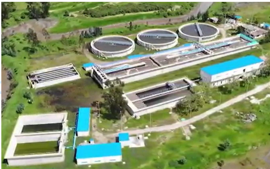
Ilustración 1. Vista General de la PTAR Chía 2
