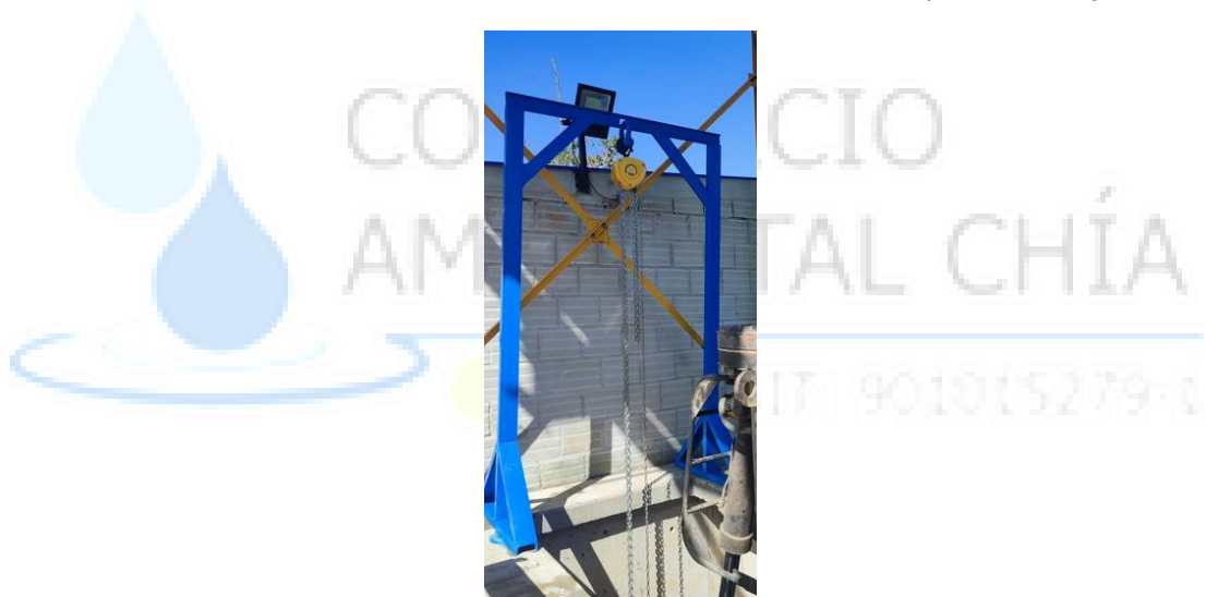
Ilustración 8. Estructura y polipastos para la rejilla deslizante
