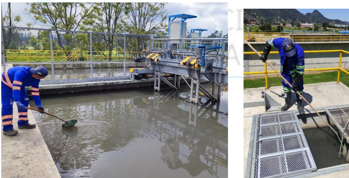
Ilustración 22. Proceso de Limpieza sobrenadantes Sedimentador Primario.
