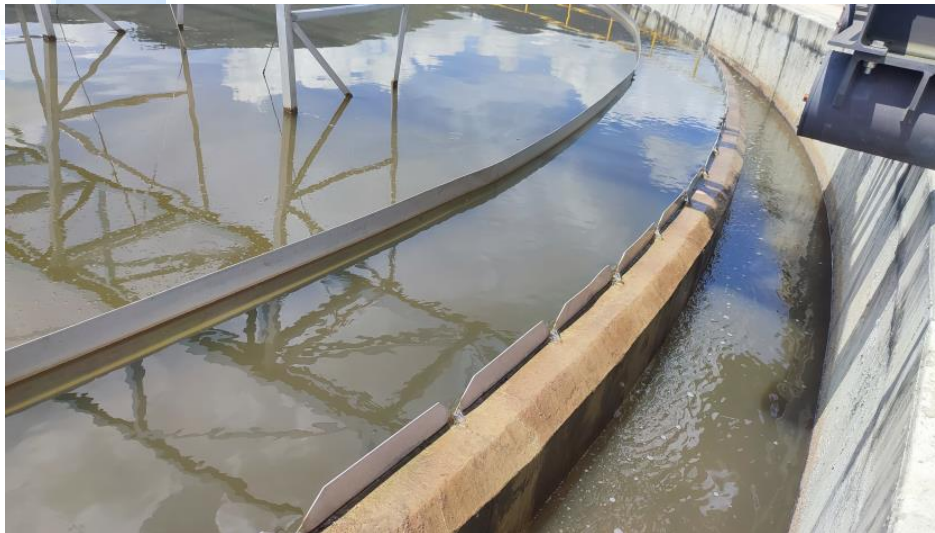
Ilustración 31. Efluente Clarificado resultado del tratamiento secundario
